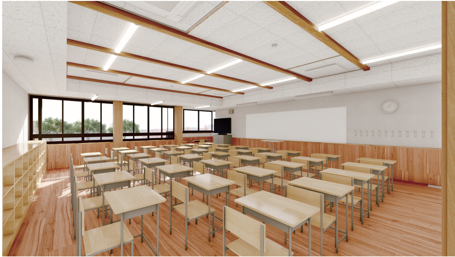
重ね梁を天井面に見せる2階普通教室（グラウンド側をみる）
