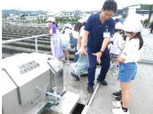
4年「松ヶ崎浄水場」
