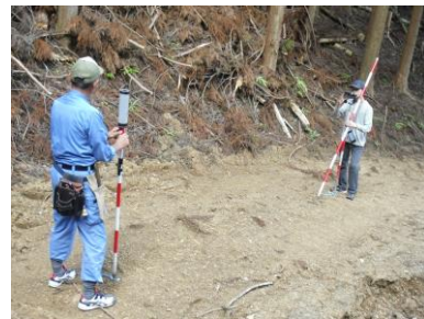
京北森林組合加工センター 林道の測量をしています
