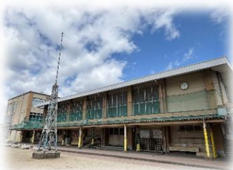
唐橋小学校体育館
